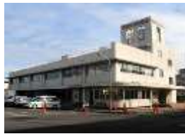
施設外観写真
