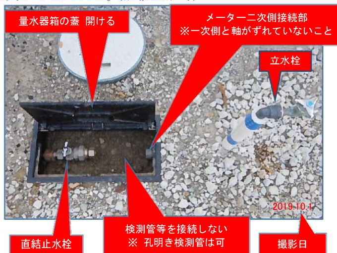
図 9-1 メーターを付けずに竣工届
