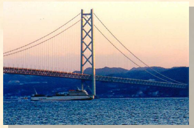
明石海峡大橋
