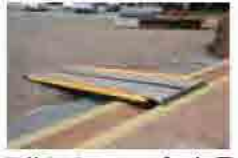
段差解消スロープの設置
