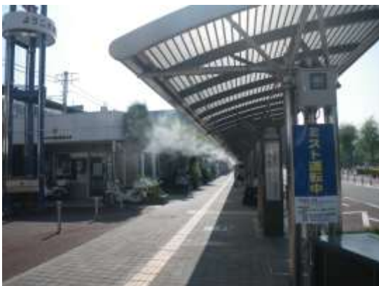
(1) 明石駅北側シェルター
