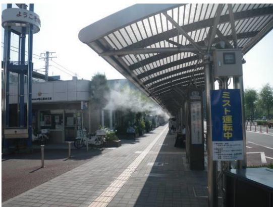
(1) 明石駅北側シェルター
