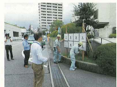
設置作業状況 ※H29.10 撮影
