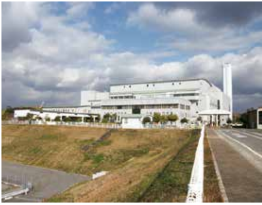
老朽化が進む現在の明石クリーンセンター
