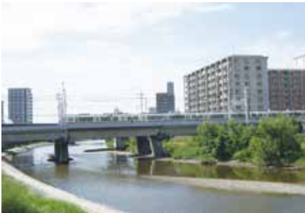
いよいよ始まる改修工事
