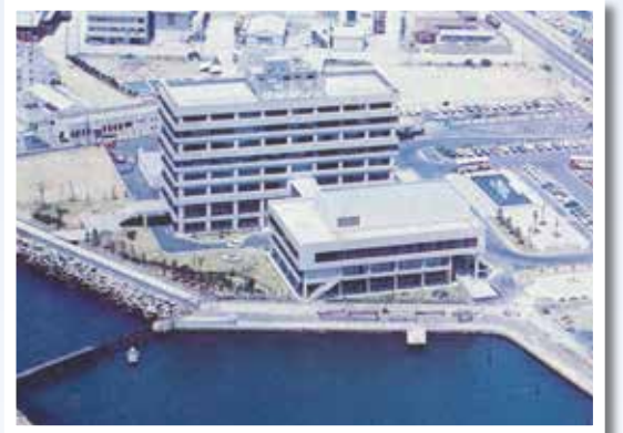
完成した頃の現庁舎
