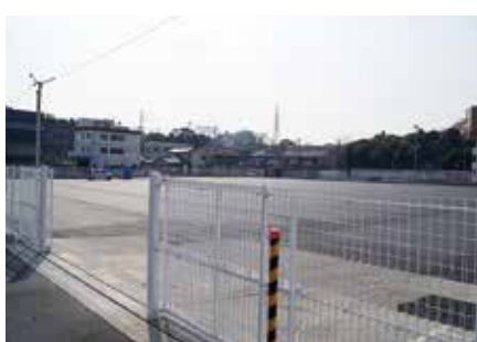
東部中学校給食センター建設予定地
