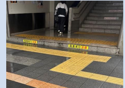
エスカレーター前の段差
