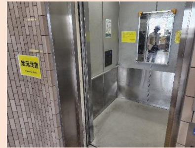
南側エレベーター
