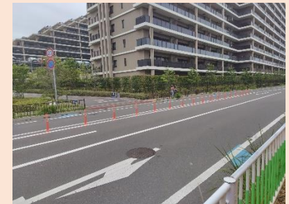
シエリア駐車場出入口
