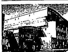
現在稼働中の明石市クリーンセンター
