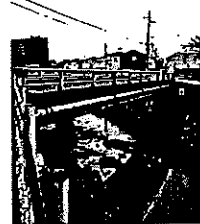
市内にも老朽管が増え計画的な改築・更新が必要に
