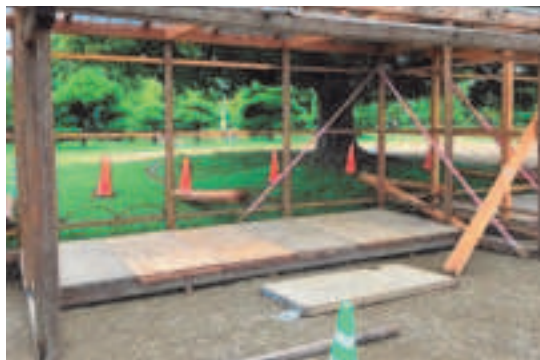
コンパネ(下面)設置
