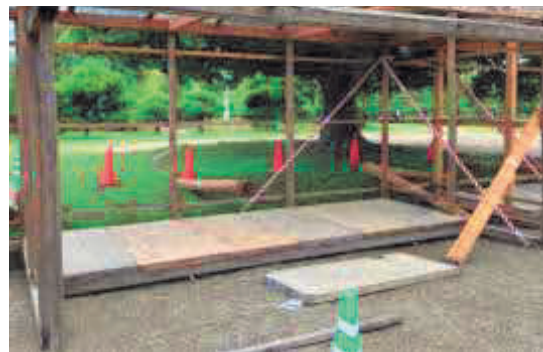
コンパネ（下面）設置
