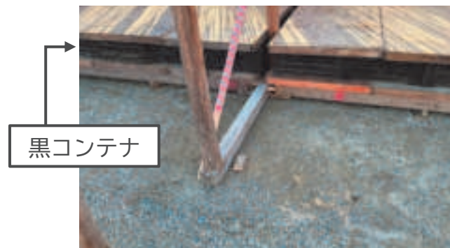
黒コンテナ、コンパネ (上面) 設置
