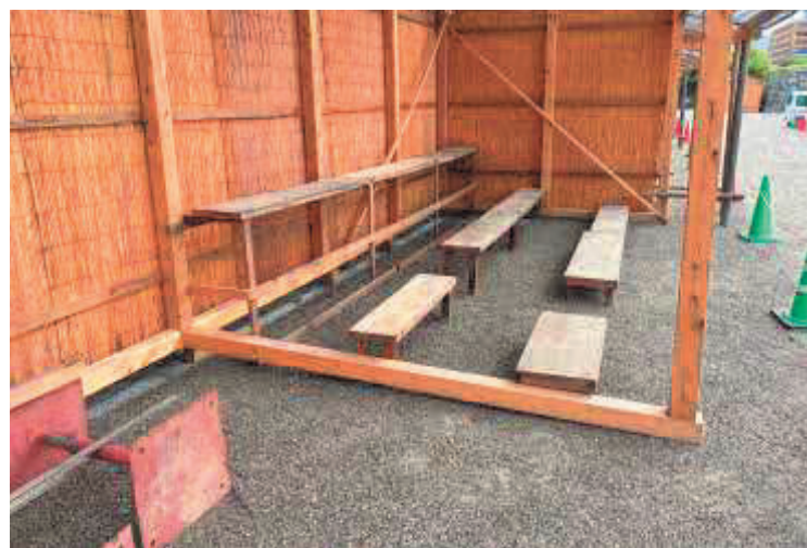
簡易木製棚設置
