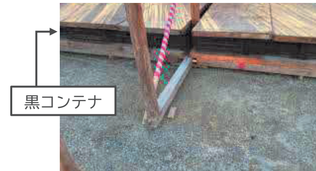
黒コンテナ、コンパネ (上面) 設置
