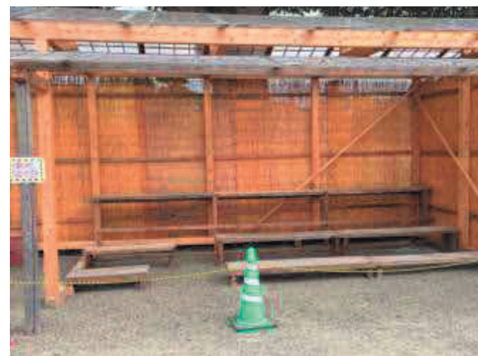
簡易木製棚設置
