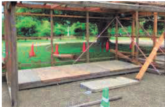
コンパネ (下面) 設置
