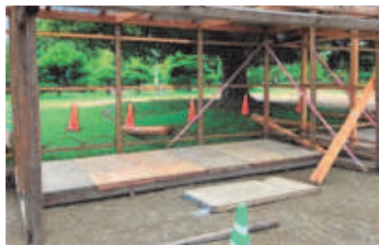
コンパネ (下面) 設置
