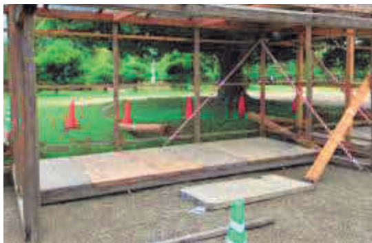
コンパネ（下面）設置
