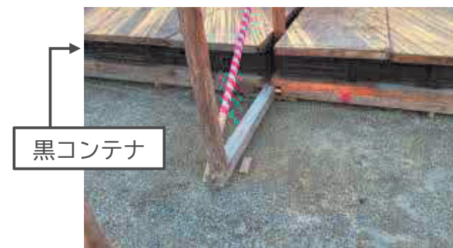
黒コンテナ、コンパネ (上面) 設置
