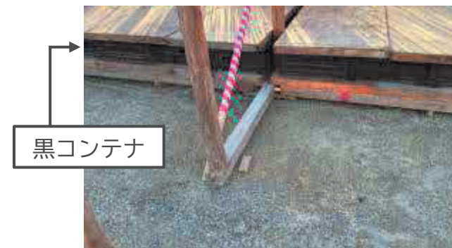
黒コンテナ、コンパネ（上面）設置
