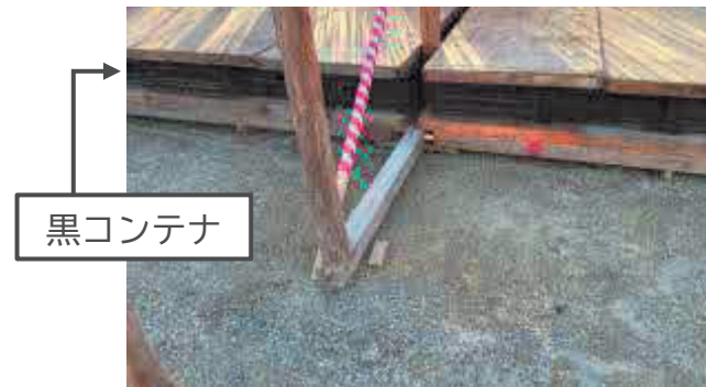
黒コンテナ、コンパネ（上面）設置
