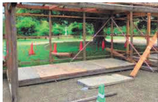
コンパネ (下面) 設置
