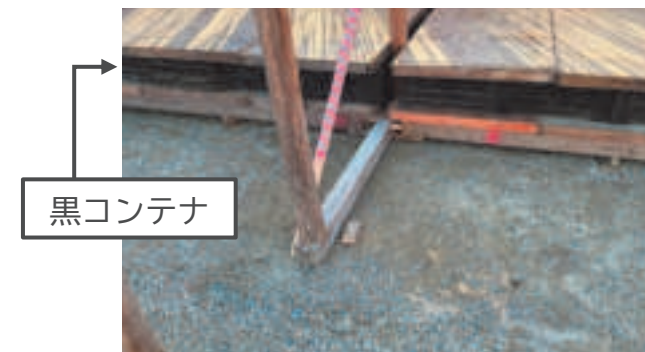
黒コンテナ、コンパネ(上面)設置
