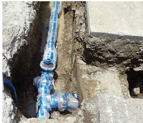
(老朽化した水道管の更新工事)
