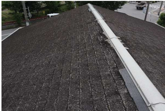
屋根水切り(3カ所で劣化、錆を認める。)
