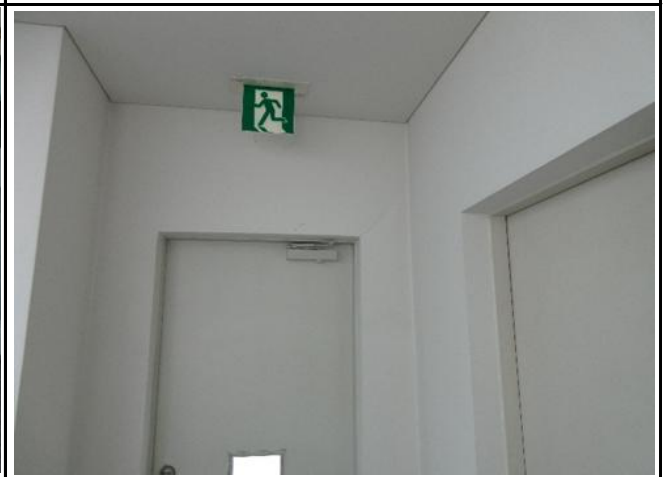
㉔研修室前廊下内壁クラック
