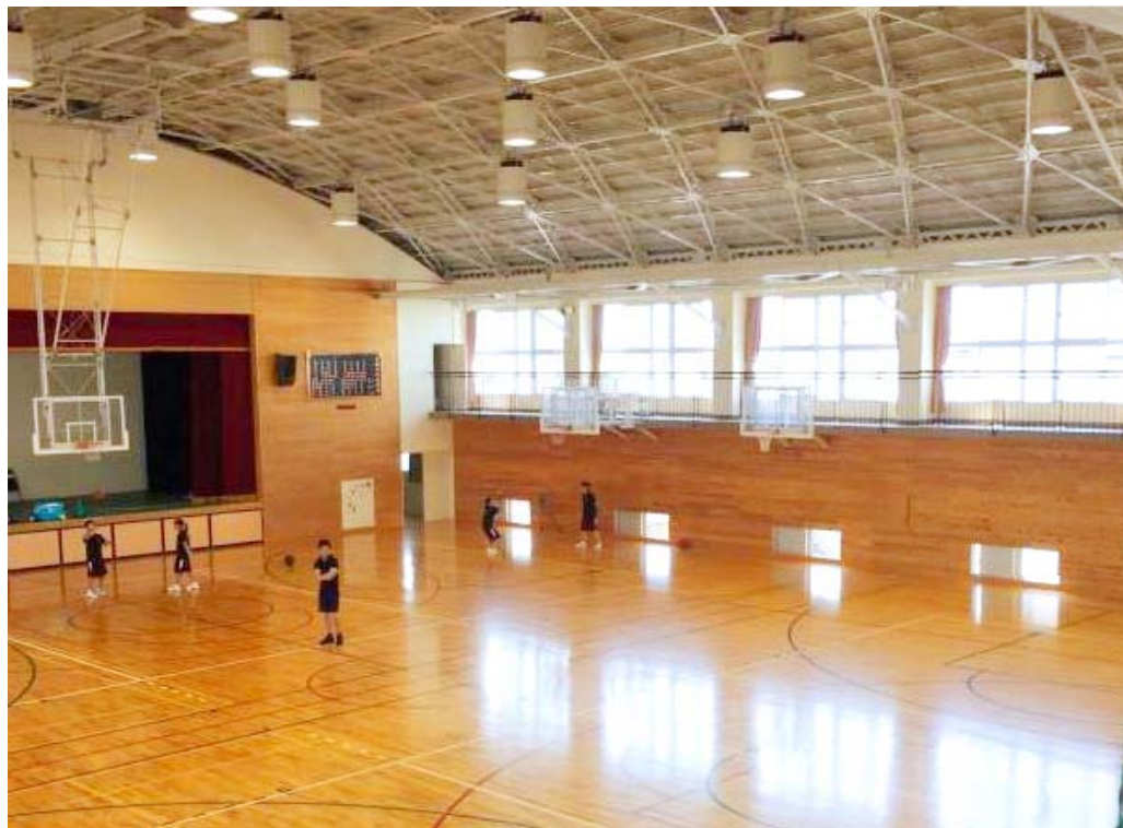
体育館エアコン設置
