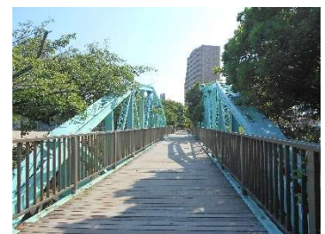
小久保跨線橋
