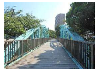
小久保跨線橋
