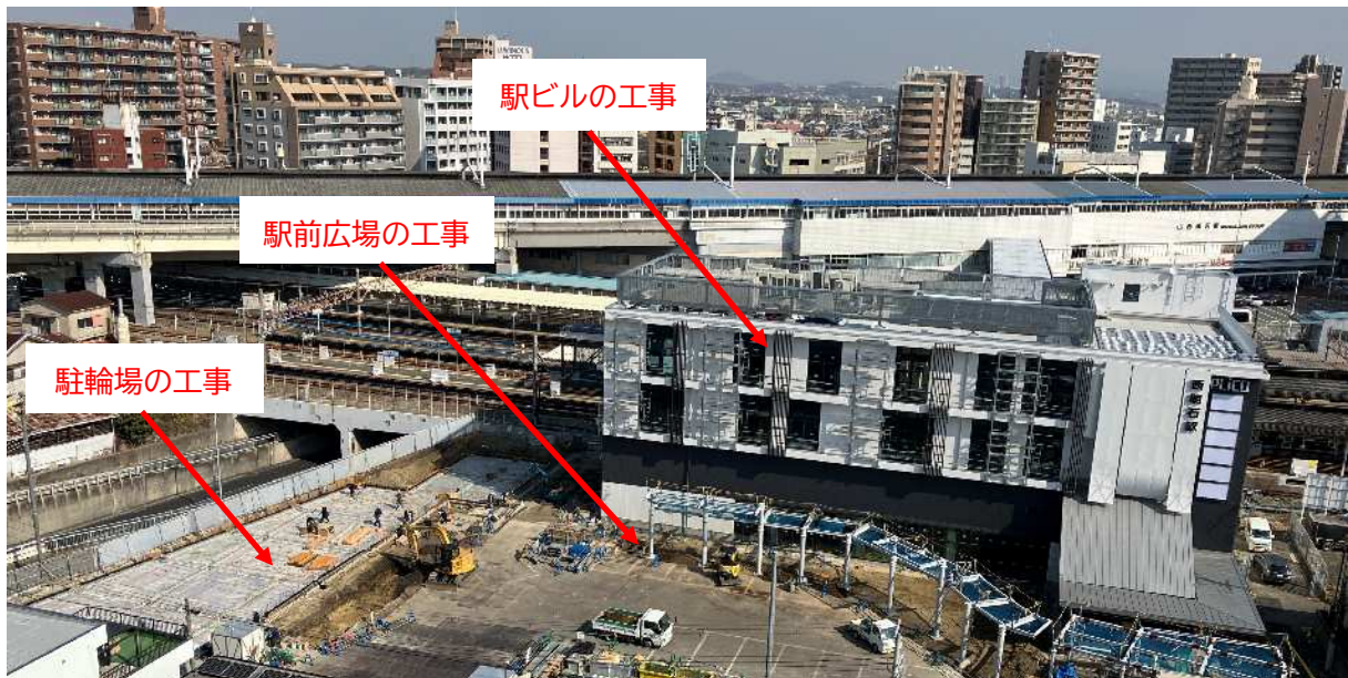
工事の様子(令和8年2月13日撮影)
