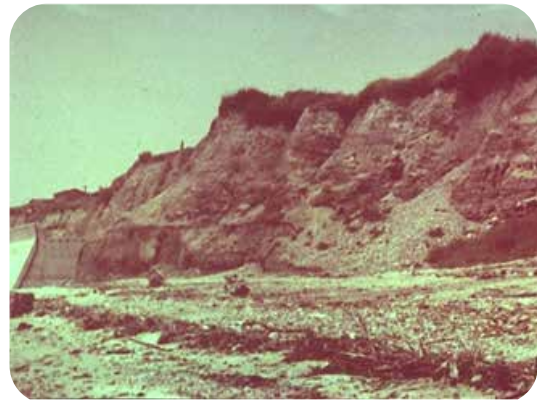
護岸の建設中（東松江地先 1967 年）
