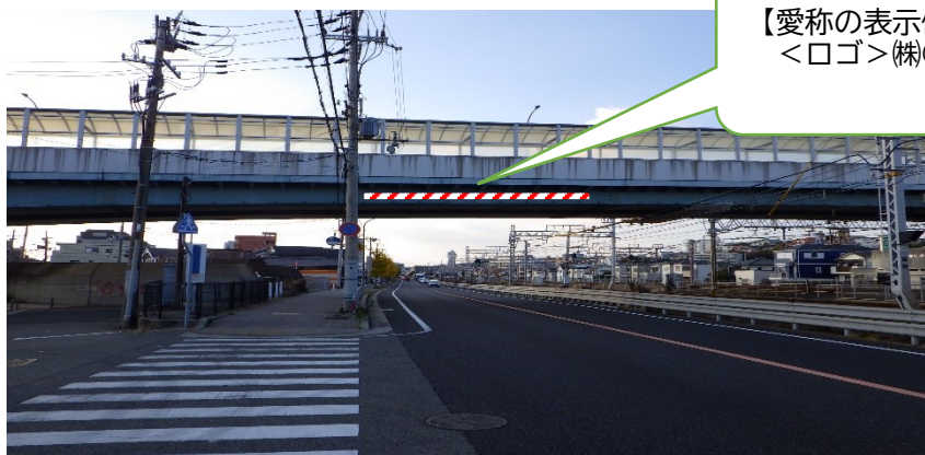
大蔵朝霧陸橋
