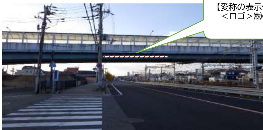
大蔵朝霧陸橋
