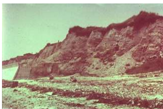
護岸の建設中(東松江地先 1967 年)
