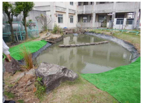
除去作業完了
