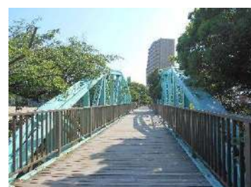
小久保跨線橋
