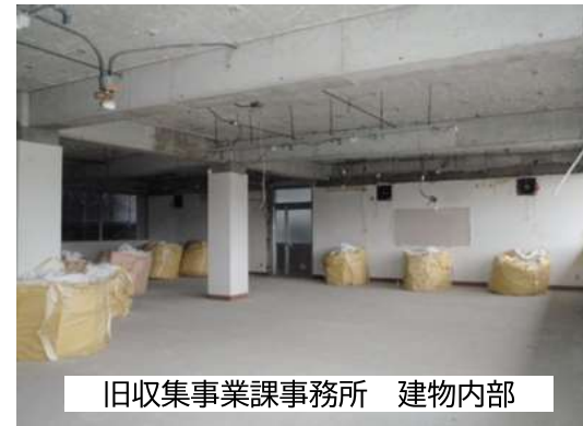
②内装解体が完了しました
