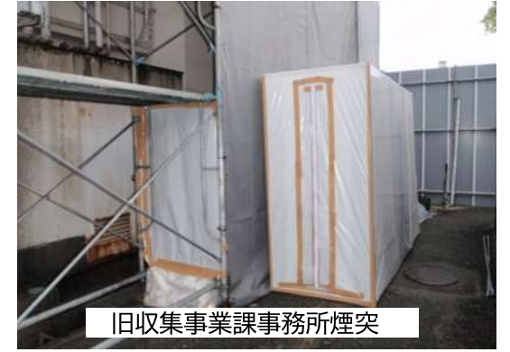
③石綿除去工事時に必要となる隔離養生および前室を設置しました
