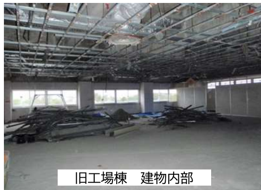
④内装解体を進めています
