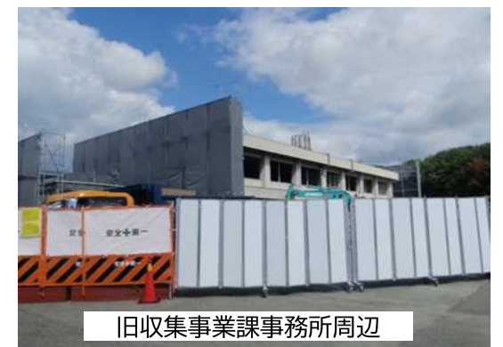
⑥建屋解体に向けて、仮囲い・養生足場を設置しました
