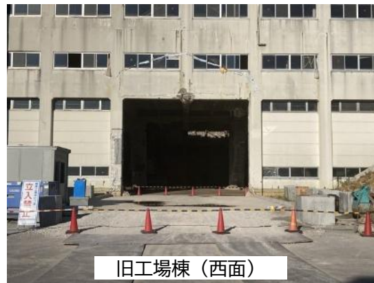
④ 重機等搬入前室 解体完了状況
