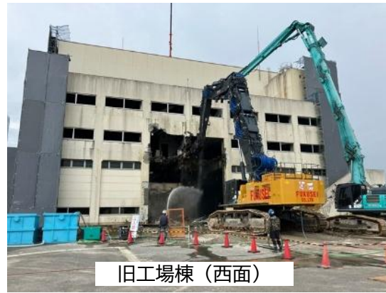
① 上屋 解体状況 (9月上旬撮影)
