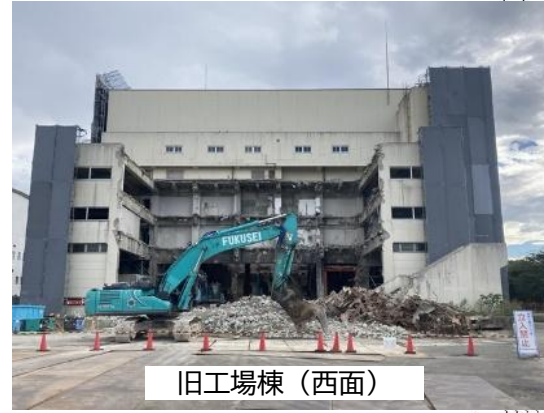
② 上屋 解体状況 (9月下旬撮影)
