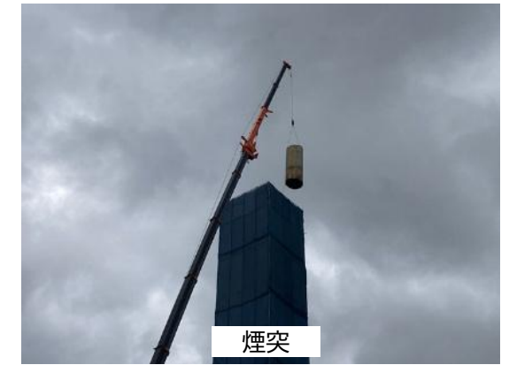
③ 内筒管 撤去状況
