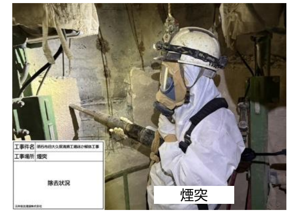
③ 内筒 耐火材撤去状況
