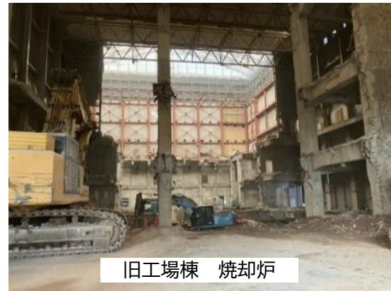
① プラント機器 解体完了状況
