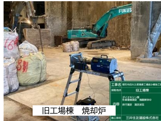
① プラント機器解体作業中 作業環境調査状況
