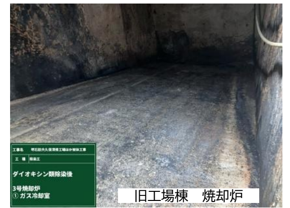
⑦ ガス冷却室 洗浄完了状況
