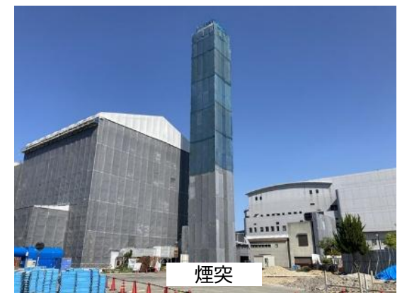
③ 外部養生足場 設置完了状況
