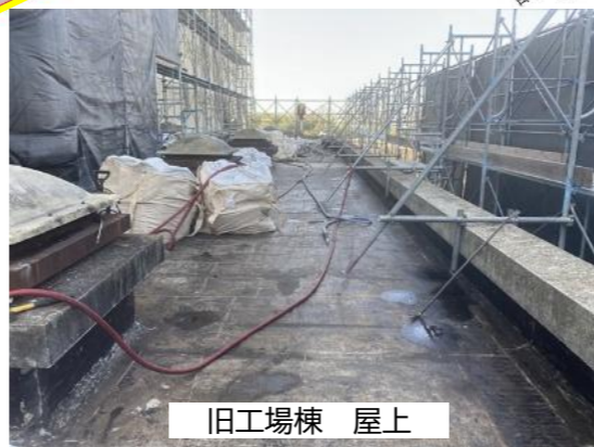
⑥アスファルト防水撤去状況
