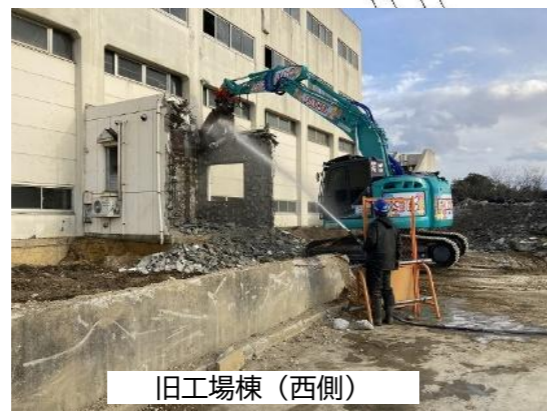
②重機出入口設置先行解体状況
