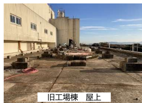
④嵩上げコンクリート撤去状況
