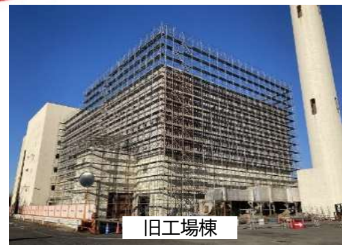
⑥旧工場棟 外部養生足場組立状況
