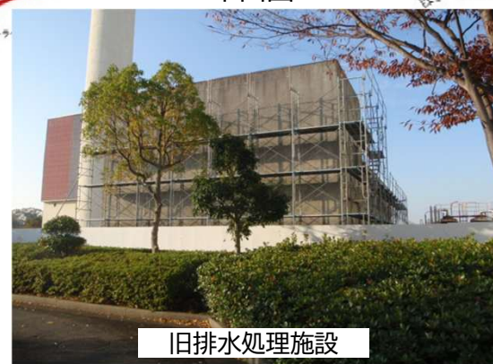
⑤旧排水処理施設 外部養生足場組立状況
