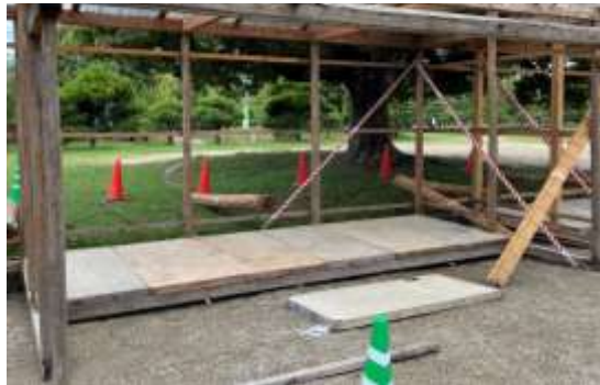
コンパネ(下面)設置
