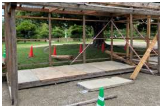
コンパネ (下面) 設置
