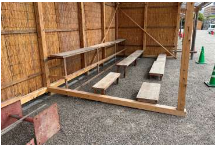
簡易木製棚設置
