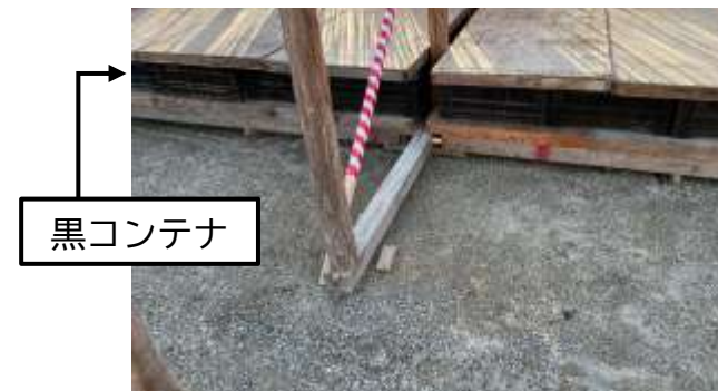
黒コンテナ、コンパネ（上面）設置
