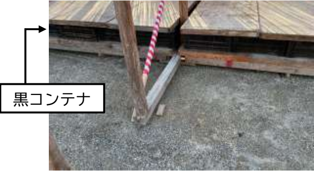
黒コンテナ、コンパネ（上面）設置
