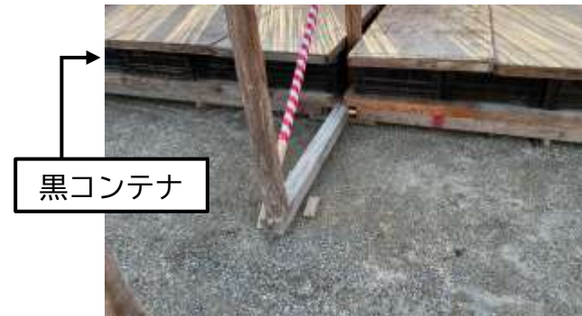
黒コンテナ、コンパネ(上面)設置
