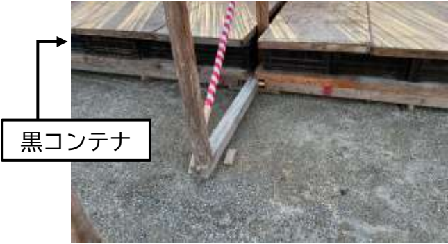
黒コンテナ、コンパネ（上面）設置
