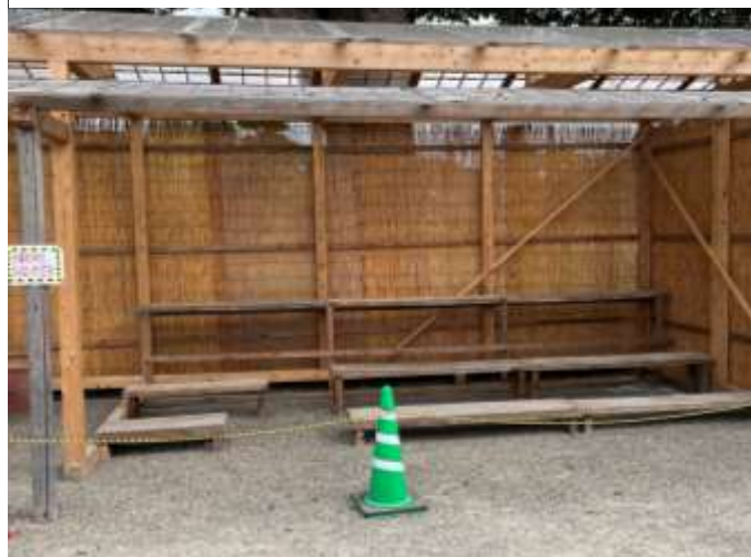
簡易木製棚設置
