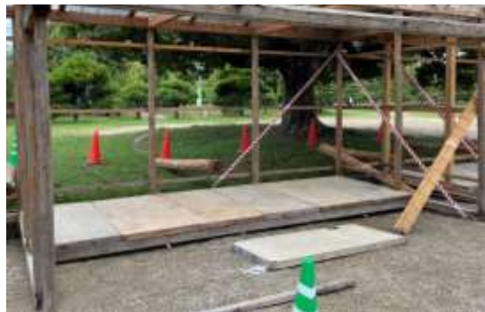
コンパネ（下面）設置
