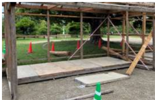
コンパネ(下面)設置
