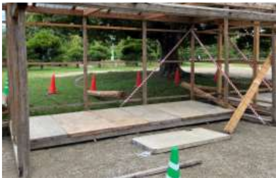
コンパネ (下面) 設置
