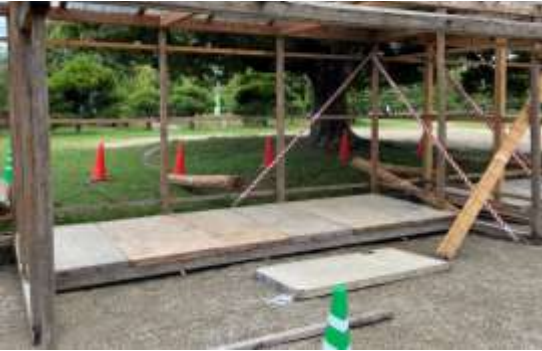
コンパネ（下面）設置
