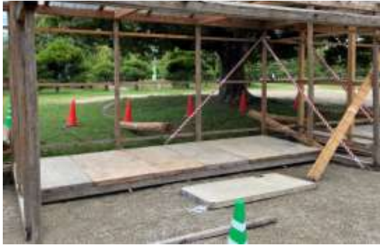
コンパネ（下面）設置
