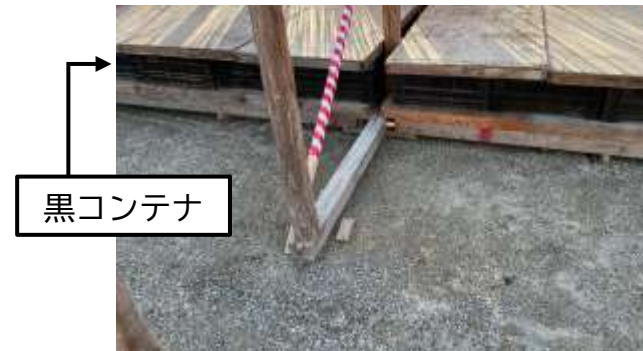
黒コンテナ、コンパネ (上面) 設置
