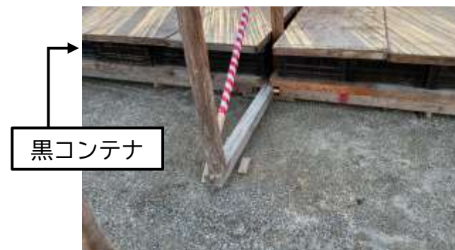
黒コンテナ、コンパネ(上面)設置
