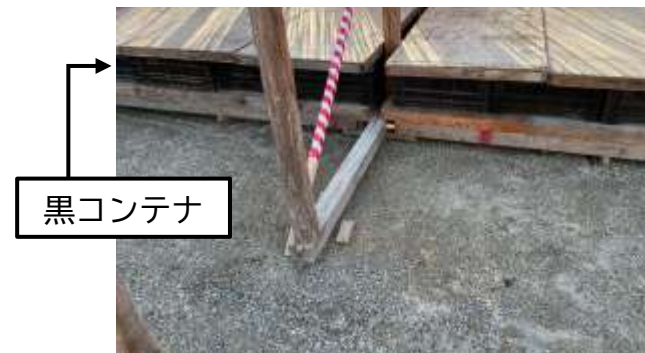
黒コンテナ、コンパネ (上面) 設置
