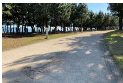
園路改修前(大蔵海岸公園)
