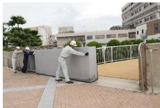
防潮ゲート点検(中崎展望広場)
