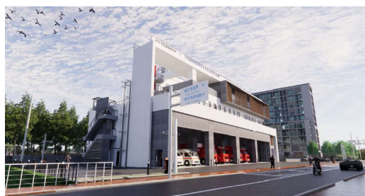
新中崎分署の建設
