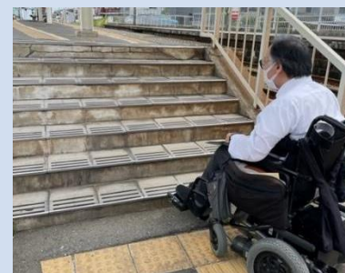
駅構内の階段
