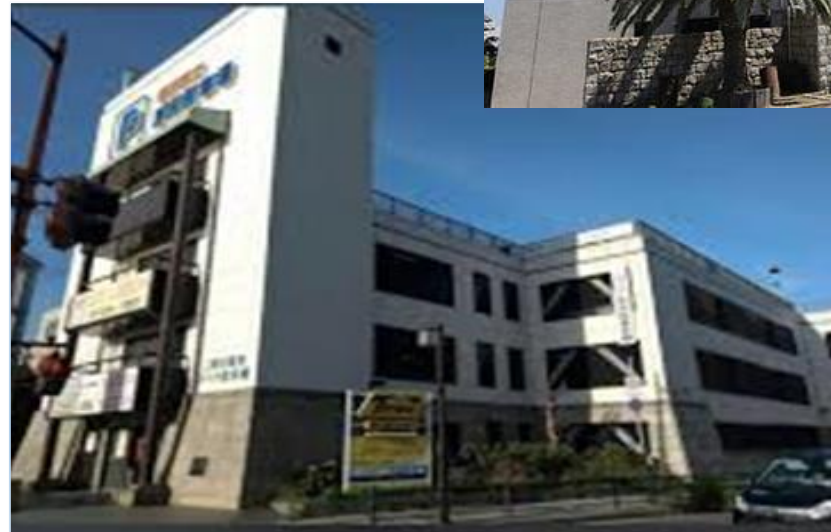
明石駅前立体駐車場
