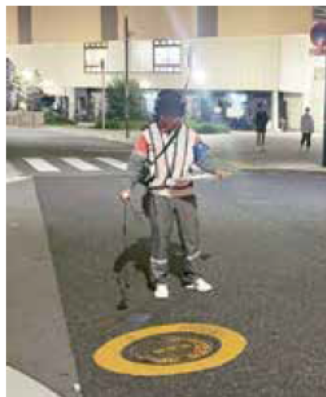
雑音の少ない夜間に行う漏水調査
