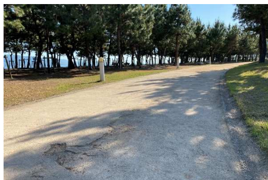
園路改修前(大蔵海岸公園)
