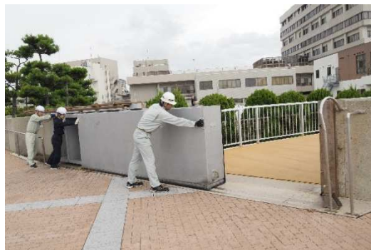
防潮ゲート点検(中崎展望広場)
