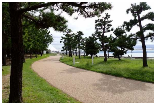
園路改修後(大蔵海岸公園)
