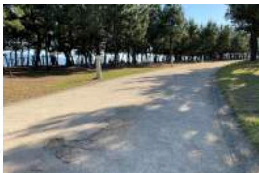
園路改修前(大蔵海岸公園)
