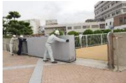
防潮ゲート点検(中崎展望広場)
