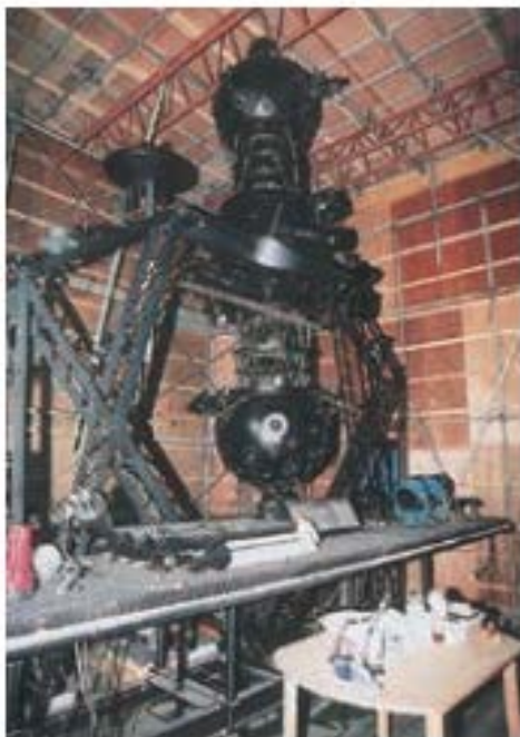
復旧工事中の養生小屋内プラネタリウム(2階)
