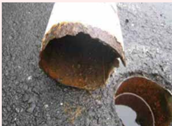
ポールの根腐れによる倒壊
