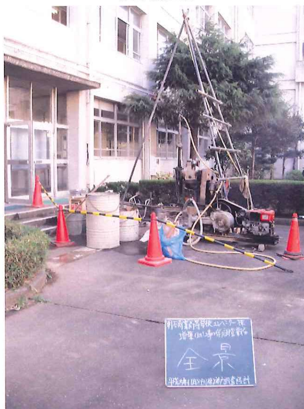
作業地点全景
