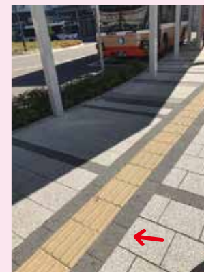
駅前の点字ブロック
