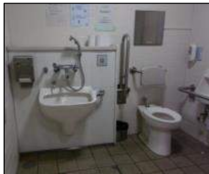
駅構内の多目的トイレ
