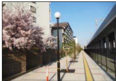
鉄道沿線に整備された歩道
