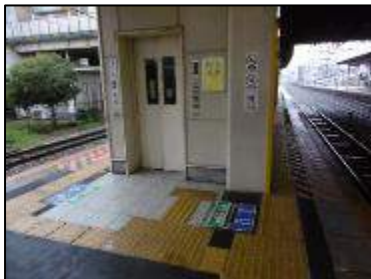
駅構内のエレベーター
