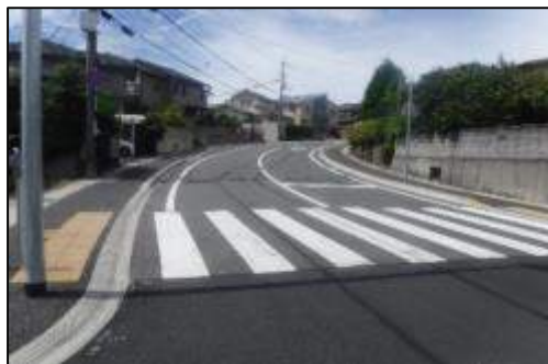
歩道の波打ち解消・段差の緩和
