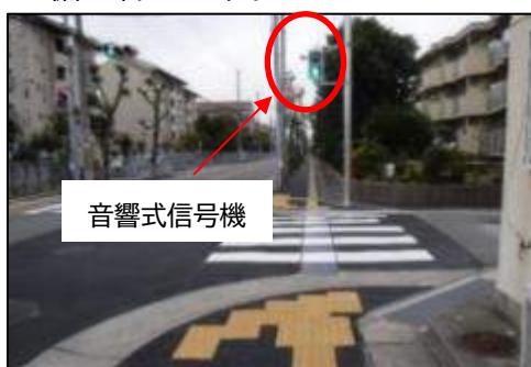
音響式信号機の設置
