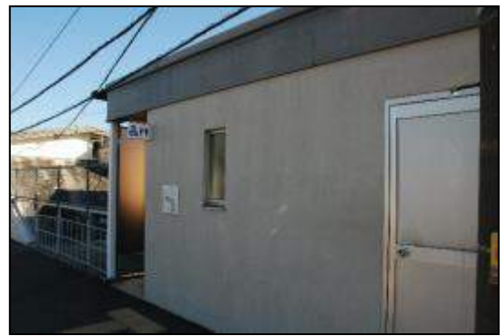
駅構内の多目的トイレ
