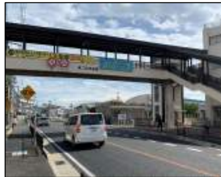
駅南のデッキ通路
