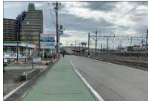
路側帯のカラー舗装(駅北側)
