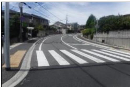
歩道の波打ち解消・段差の改修
