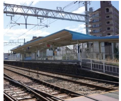
駅構内のスロープ
