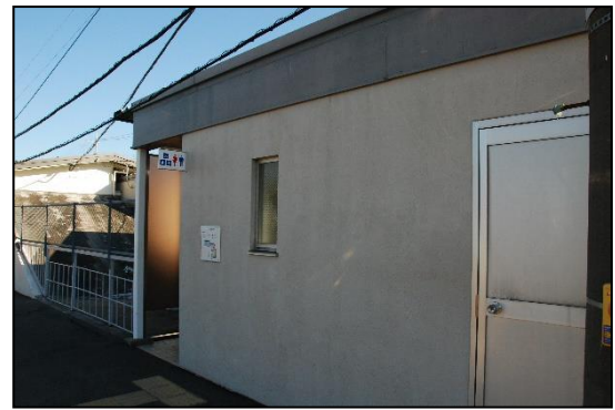
駅構内の多目的トイレ
