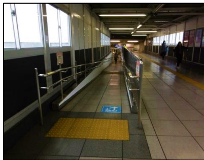
駅構内の連絡通路
