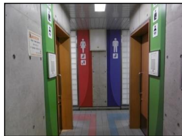
JR朝霧駅構内のトイレ
