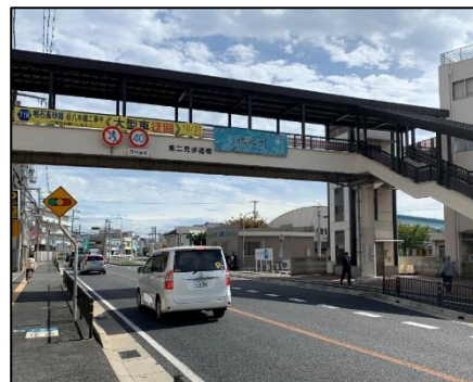
駅南のデッキ通路
