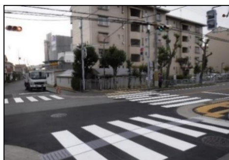
エスコートゾーンの設置
