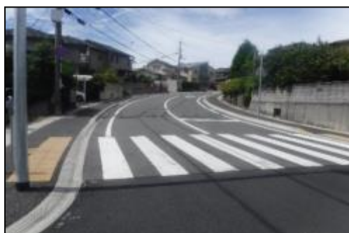
歩道の波打ち解消・段差の改修
