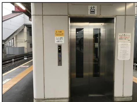
駅構内のエレベーター
